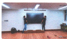
SMART TOUCH 2023 | การติดตั้ง
